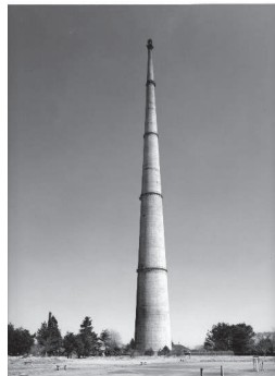
福島県南相馬市原町区に聳え立っていた原町無線塔。高さ 201 メートルの東洋一の鉄塔は昭和 57 年、老朽化のため解体された。
